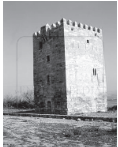
Torre dels Hospitalers de Fraga
